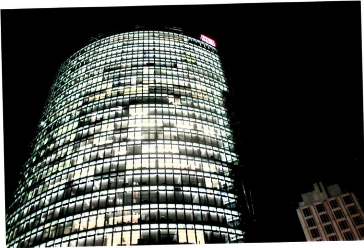
Das Hochhaus/Verwaltung der Deutschen Bundesbahn
