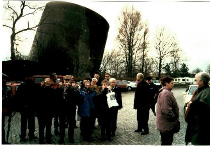
der „Schiefe Turm von Sande“
